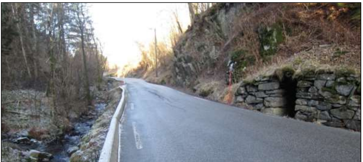
Figur 32; Bekk og jordkjellar tett opp mot vegen. Nordover frå Sundet pregar bratt sideterreng på begge sider av vegen reiseopplevinga eit godt stykke.
