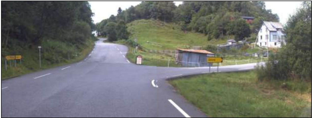
Figur 16; Slutten av strekninga. Til høgre fortsett Ådlandsvegen, medan fv.246 Håtuftvegen startar rett fram. Foto: SVV.
