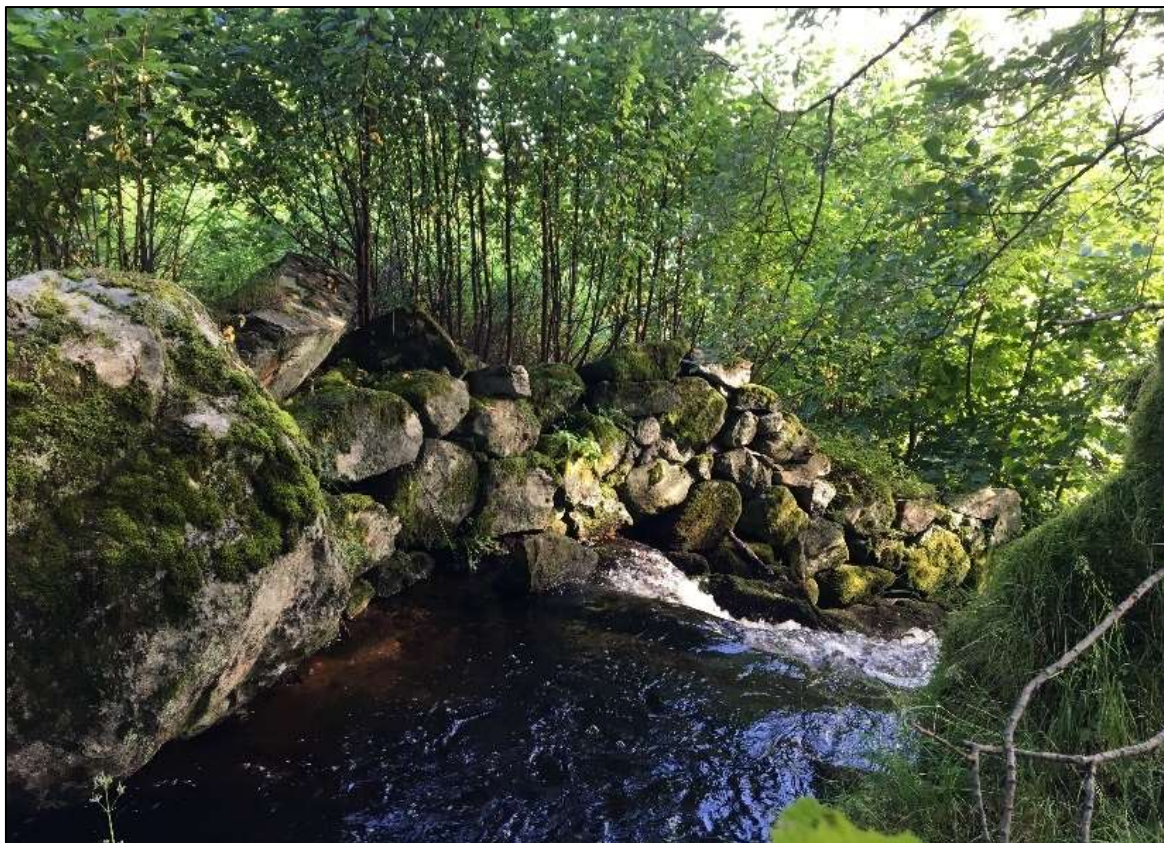
Figur 58; Fossen ned frå kvernhuset er steinsett med ein solid natursteinsmur som er i god stand.
