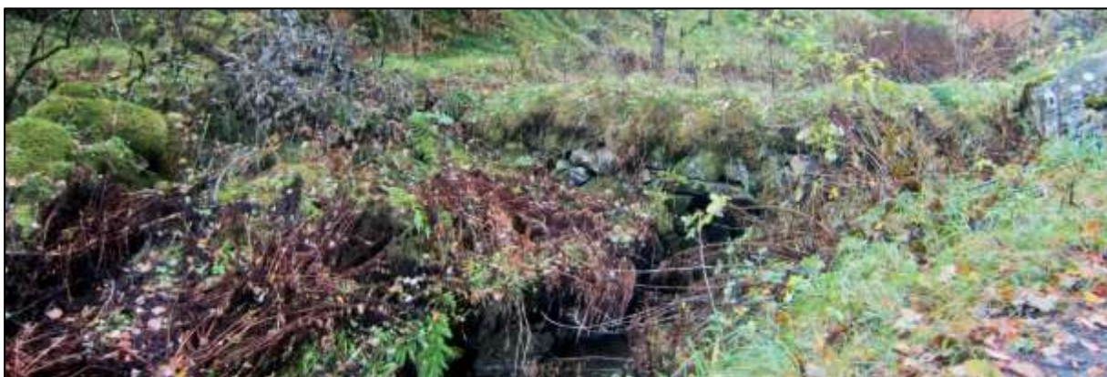
Figur 34; Gamle elvemurar og ei hellebru over bekken.
