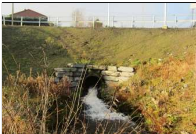
Figur 25; Utløp frå stikkrenna under Ådlandsvegen ved Fossekrysset.
