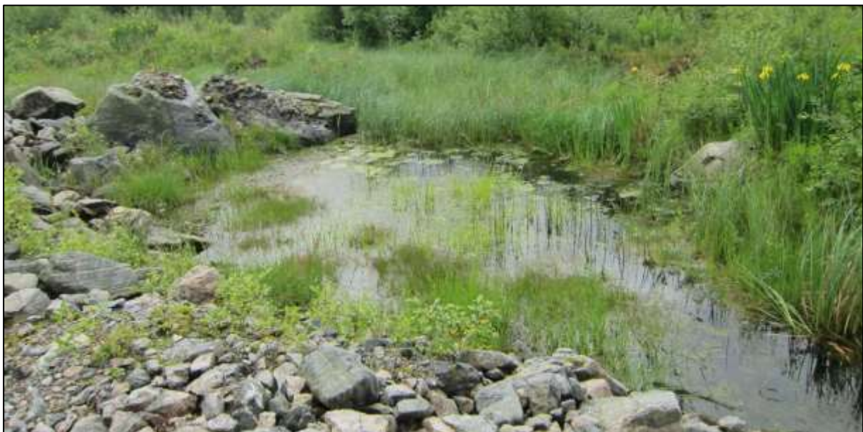
Figur 53; Restar av ope vatn i våtmarka og steinfylling i sone 7.
