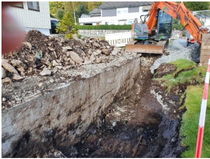
Mur fundamentert på fast fjell
