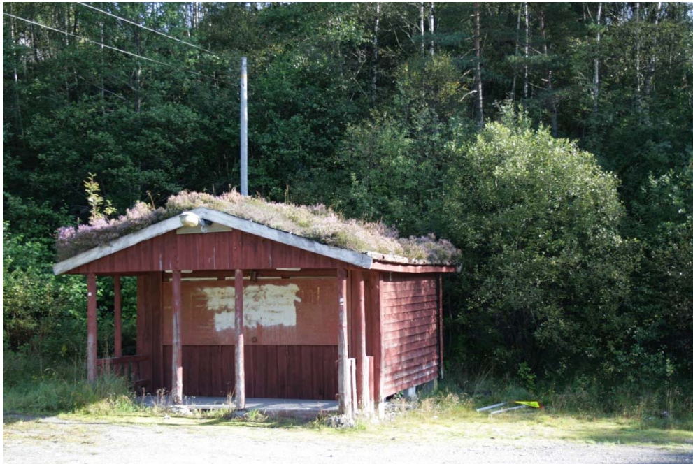
Figur 36 Bygning som er føreslått innløyst.
