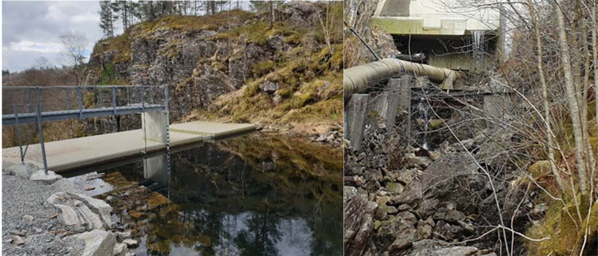
Figur 16 Husdalsvatnet har utløpet via demning der store delar av vatnet førast vidare i røyrgate. Det er relativt liten vassføring i sjølve elvedraget. Foto: Hilde Sanden Nilsen.
