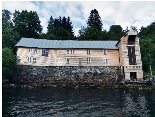
Etter oppgradering av ytterfasader/tak
