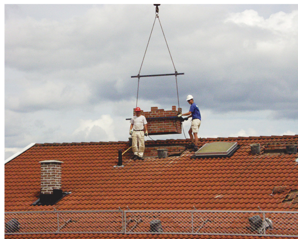
Fig. 42 a Montering av prefabrikkert skorstein av tegl Metoden er besparende både når det gjelder tid og stillaskostnader, spesielt på blokkbebyggelse. Foto: Roar Gulbrandsen
