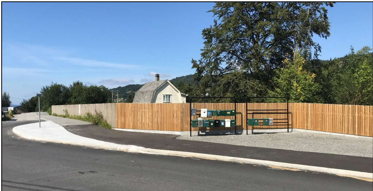
Foto viser eksisterende bygg innenfor planområdet bak eksisterende gjerde mot gangveg langs fylkesvegen og i kryssområdet, sett fra fylkesvegen.
