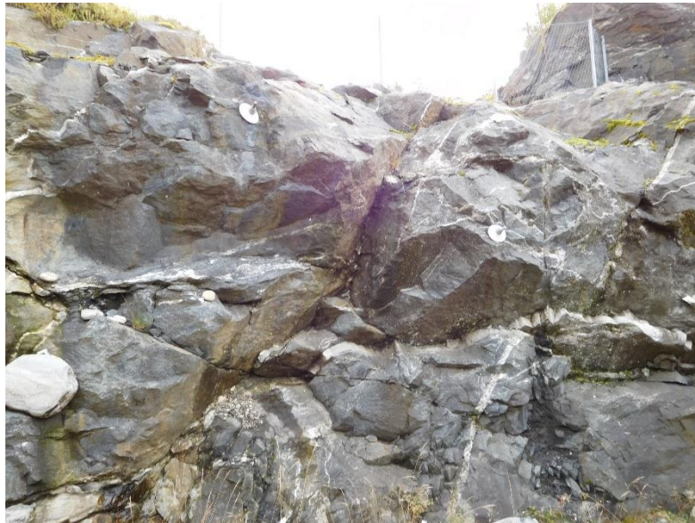
Fig.11: Eksempel på fjelltype på stedet. En mørk amfibolitt, omvandlet basalt. Bildet er fra østsiden av tomannsboligen. Vi ser at skjæringen er sikret ved bolter i fjell.
