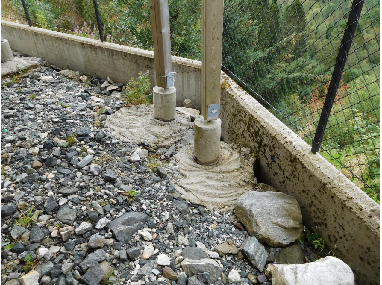
Fig.20: Armert støpt murkant under terrassen, 28 B. Murkanten er ikke i bevegelse. Den er i vater.
