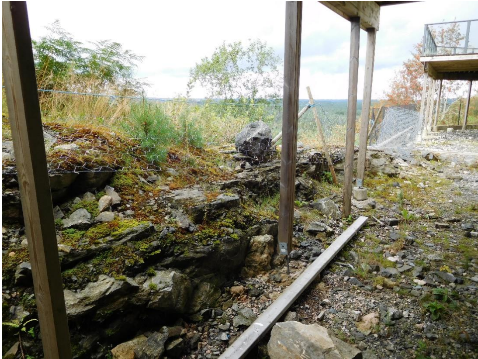
Fig.9: Vestre side av tomannsboligen. Grønnfjelli 28 A og B. Nærmest ser vi at 28 A er fundamentert på godt stabilt fjell. En amfibolitt. Lengst borte er Grønnfjelli 28B. Terrassen er fundamentert på en steinfylling.
