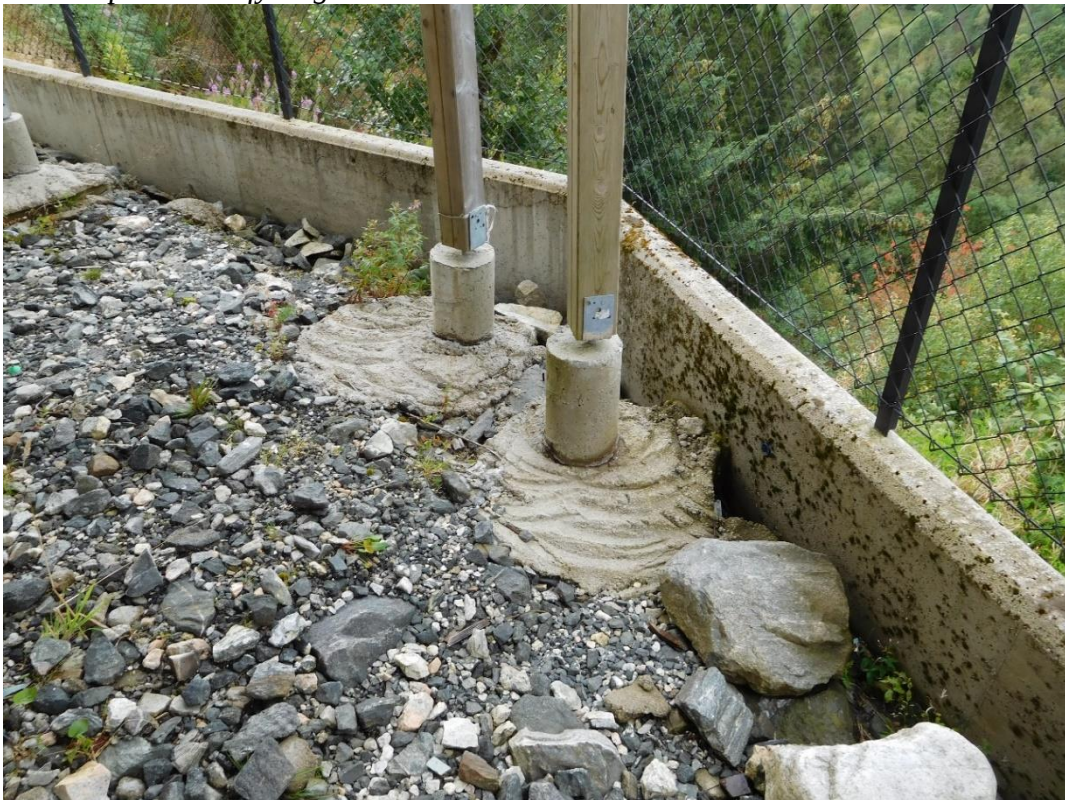
Fig.9: Vestre side av tomannsboligen. Grønnfjelli 28 A og B. Nærmest ser vi at 28 A er fundamentert på godt stabilt fjell. En amfibolitt. Lengst borte er Grønnfjelli 28B. Terrassen er fundamentert på en steinfylling.
