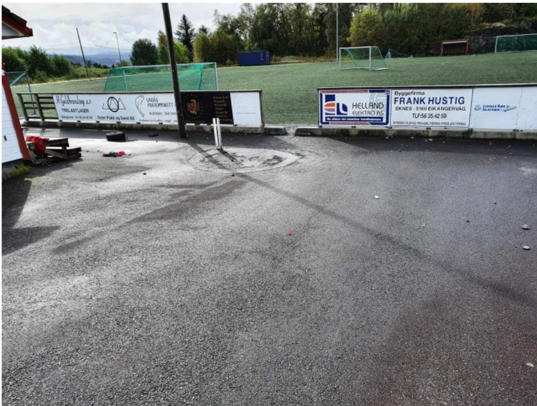
Fig.9 Asfaltareal inn mot baneingang. Tette sandfangskummer
