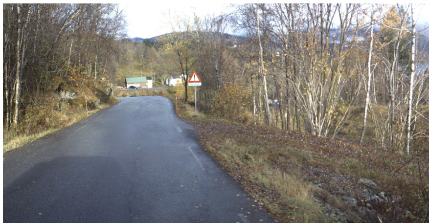
Vegbiletet av aktuelle avkøyrsløsepunkt.
