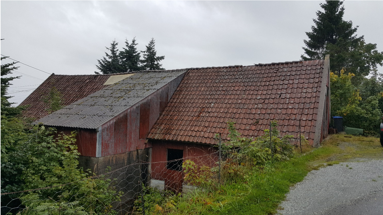
Fasade sett fra VEST
