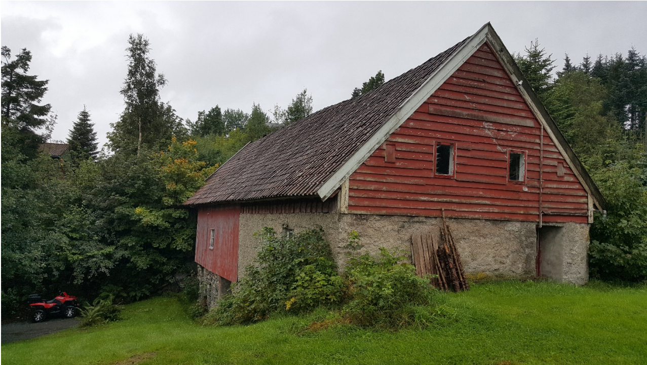
Fasade sett fra ØST
