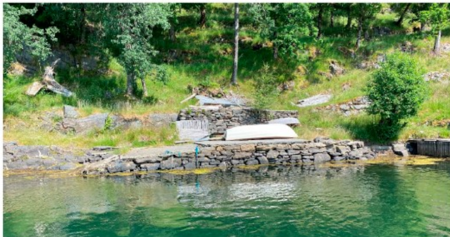
Bilete av naustetomta lagt ved søknaden – noverande situasjon sett frå sjø
