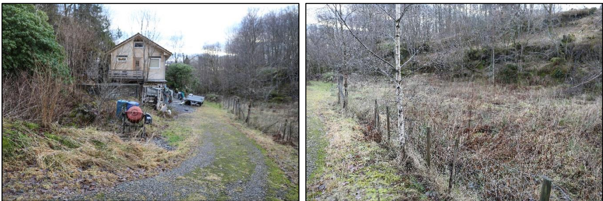
Fig. 15. Avsnitt øverst i tiltaksområdet der det er planlagt VA-anlegg, P-plass og ny/oppgradert vei ned til Litlevågen. 9. desember 2020. Foto: A. Håland.
