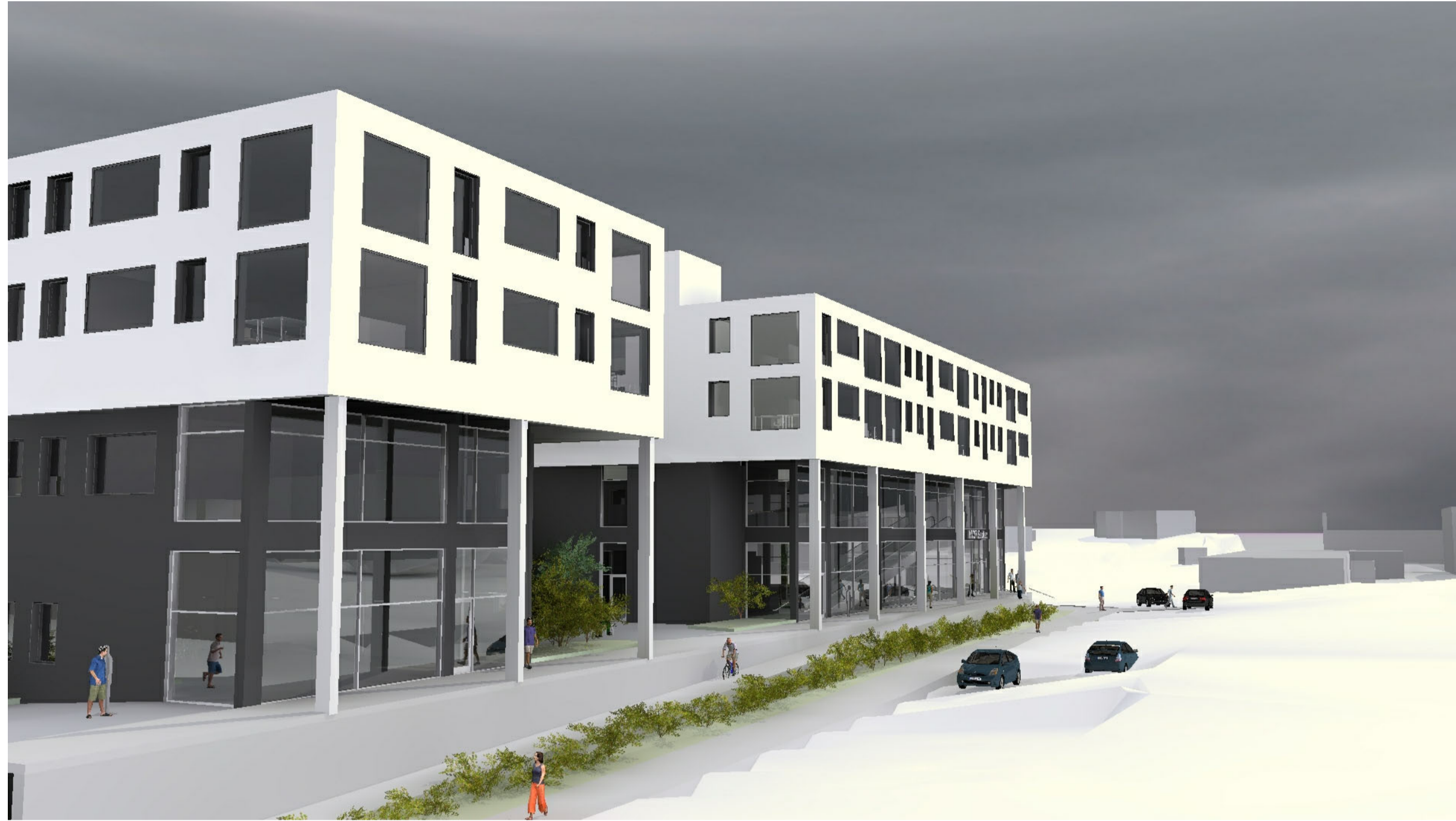
Inngangsparti fra Kvassnesvegen fra nord- vest
