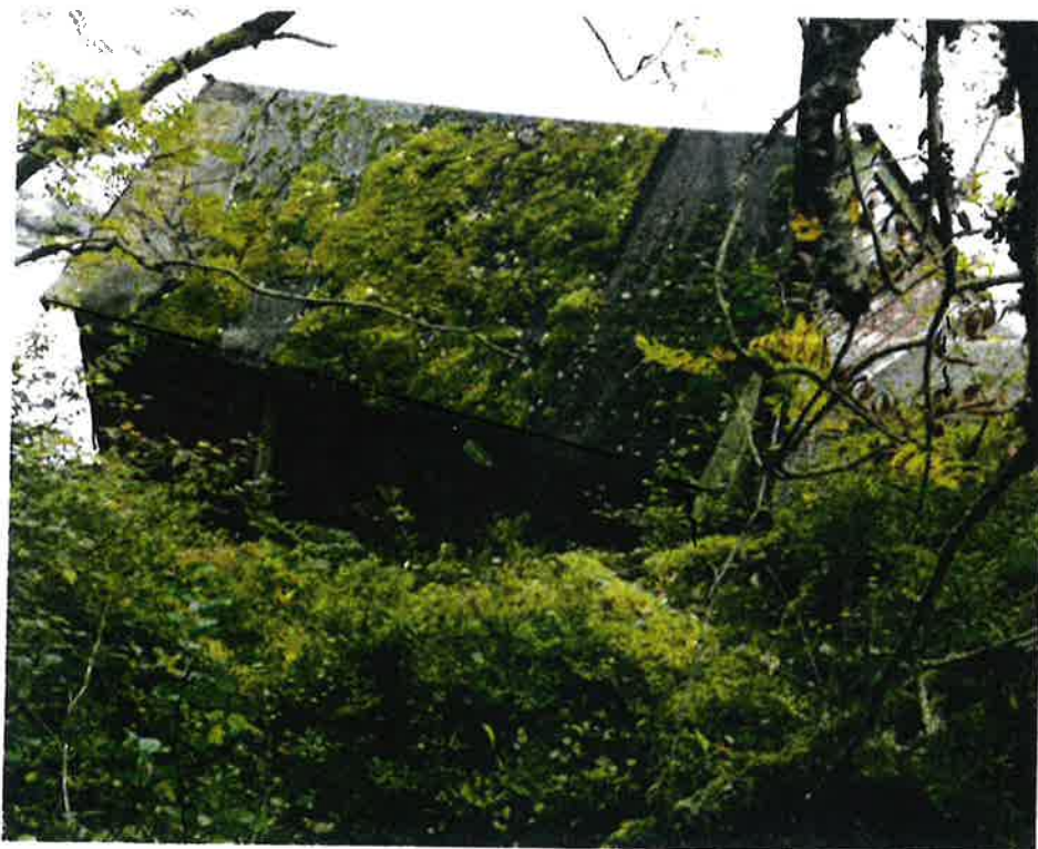
4. Baksiden av naustet. Rehab: Utbedring av tak
