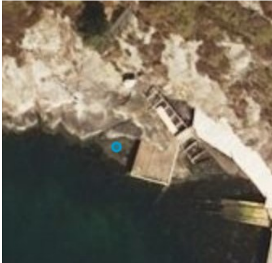
Etablert brygge sett frå sjø
