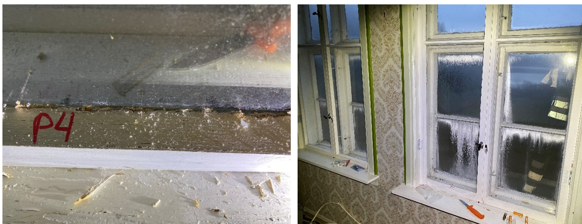
Figur 15: Det er ikke påvist asbest i vinduskitt
