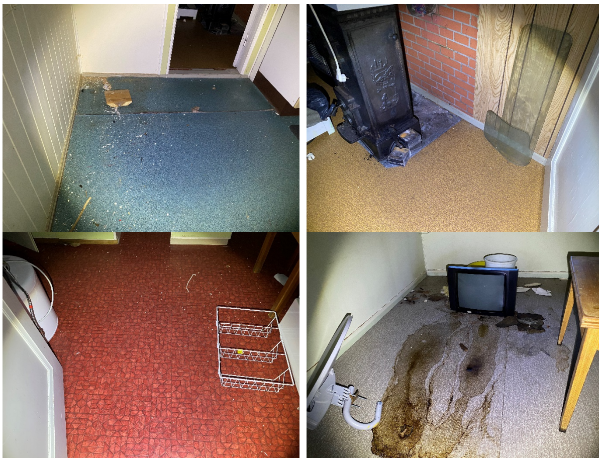
Figur 12: Jute- og vinylbelegg av ulike typer er alle farlig avfall
