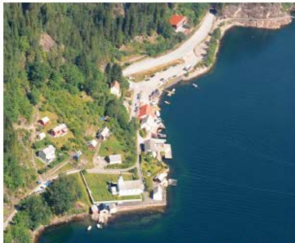
Figur 41: På Vikanes er det arealet rundt kyrkja som er mest attraktivt for allmenta. Elles er arealet i stor grad privatisert av private kaiar og bygg av eldre dato. Bevaringsverdig bygningsmiljø.
