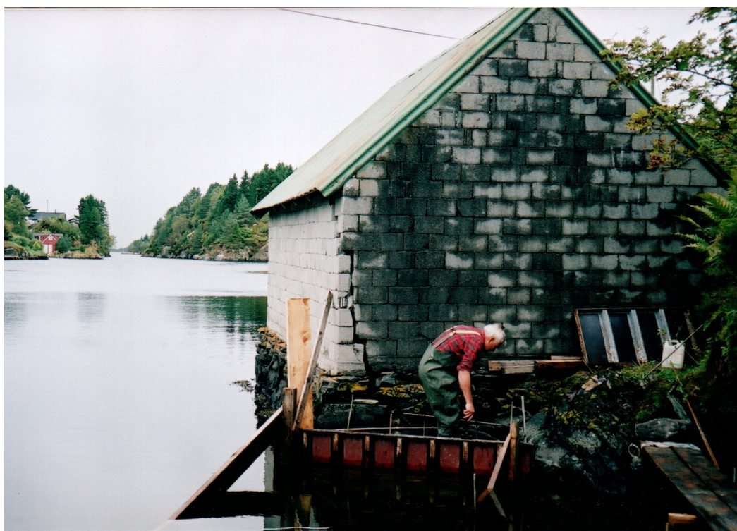
Vår far/svigerfar i arbeid med å sikre naustet.
