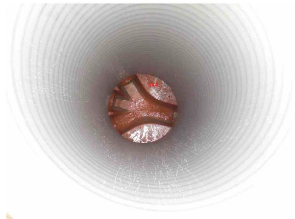
SP61SK428052108122A.jpg, 00:01:59, 19.10m Inspeksjon fullført / i SK4
