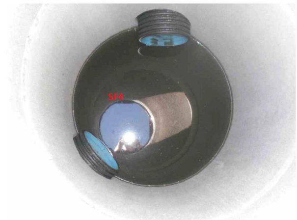
OK2SF427052116152A.jpg, 00:03:14, 25.08m Inspeksjon fullført / i SF4
