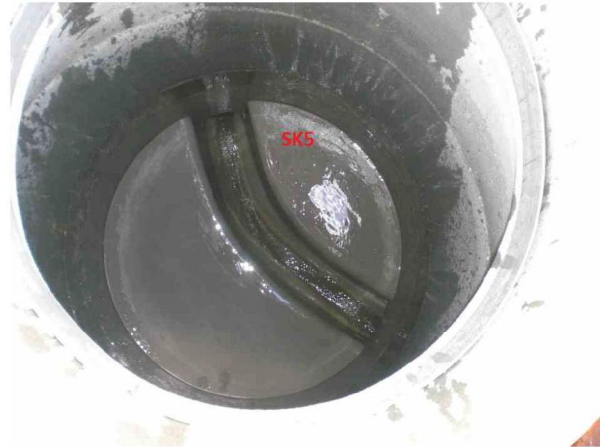
SK5SK628052108241A.jpg, 00:00:00, 0.00m Start inspeksjon / i SK5
