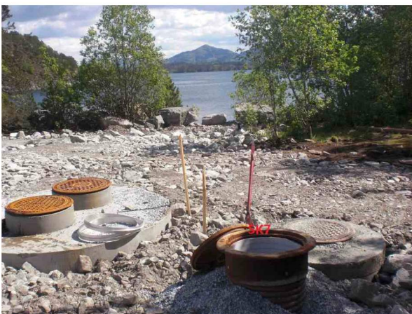
SK6SK728052108292B.jpg, 00:02:08, 25.50m Inspeksjon fullført / i SK7
