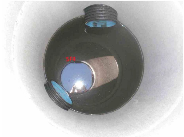
SF4OK327052116341A.jpg, 00:00:00, 0.00m Start inspeksjon / i SF4
