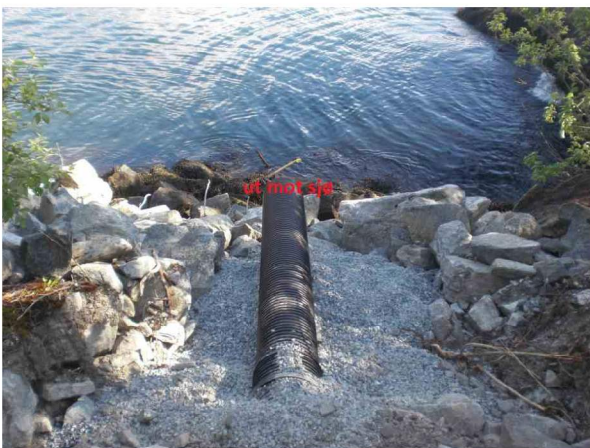
OK3Ut mot sjø27052116382B.jpg, 00:03:23, 26.21m Inspeksjon fullført / Ut mot sjø
