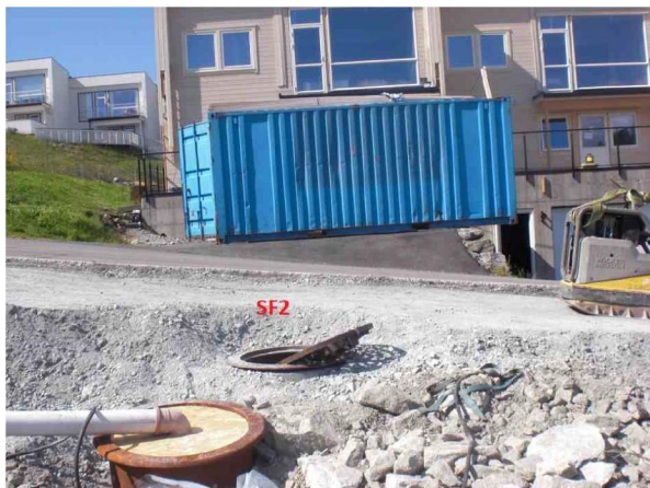
SF2SF327052115451B.jpg, 00:00:00, 0.00m Start inspeksjon / i SF2
