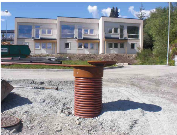
SF3OK227052116042B.jpg, 00:01:06, 4.59m Tilkopling, Prefabrikkert grennrør. av 7 Kl. til 11 Kl.
