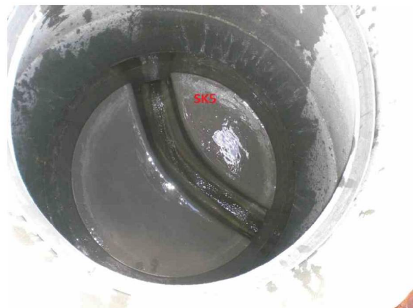
SK4-1SK528052108212A.jpg, 00:01:01, 12.40m Inspeksjon fullført / i SK5
