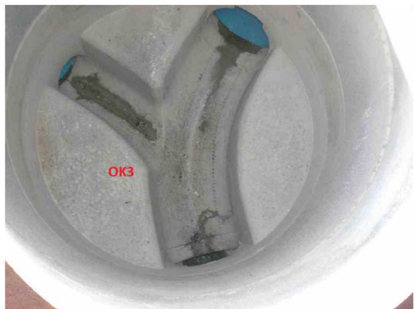
SF4OK327052116342A.jpg, 00:02:35, 19.90m Inspeksjon fullført / i OK3
