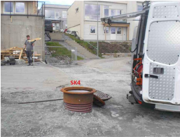
SK4SK4-128052108181B.jpg, 00:00:00, 0.00m Start inspeksjon / SK4
