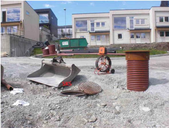
SK5SK628052108241B.jpg, 00:00:00, 0.00m Start inspeksjon / i SK5
