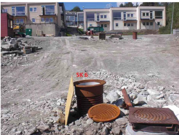
SK5SK628052108242B.jpg, 00:01:58, 23.40m Inspeksjon fullført / i SK6
