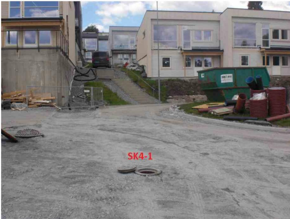
SK4-1SK528052108211B.jpg, 00:00:00, 0.00m Start inspeksjon / i SK4-1
