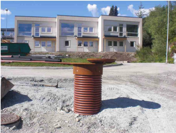
OK2SF427052116151B.jpg, 00:00:00, 0.00m Start inspeksjon / i OK2
