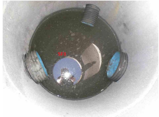
SF3OK227052116041A.jpg, 00:00:00, 0.00m Start inspeksjon / i SF3
