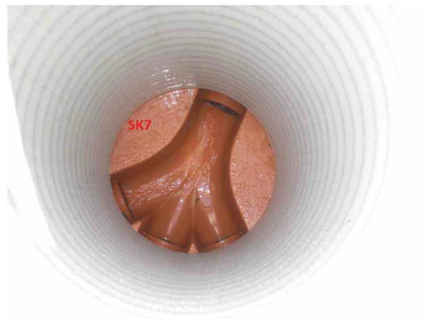
SK6SK728052108292A.jpg, 00:02:08, 25.50m Inspeksjon fullført / i SK7
