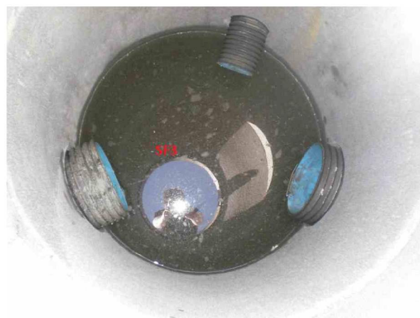
SF2SF327052115452A.jpg, 00:02:29, 18.93m Inspeksjon fullført / i SK3
