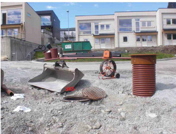
SK4-1SK528052108212B.jpg, 00:01:01, 12.40m Inspeksjon fullført / i SK5
