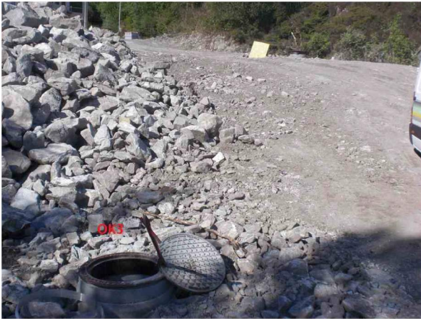
OK3Ut mot sjø27052116381B.jpg, 00:00:00, 0.00m Start inspeksjon / i OK3
