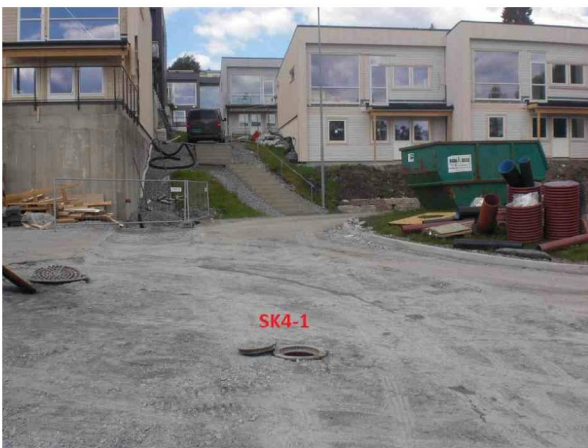
SK4SK4-128052108182B.jpg, 00:00:26, 4.00m Inspeksjon fullført / i SK4-1
