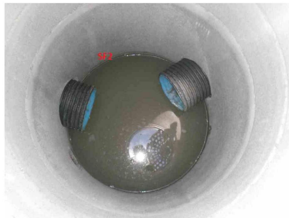
SF2SF327052115451A.jpg, 00:00:00, 0.00m Start inspeksjon / i SF2
