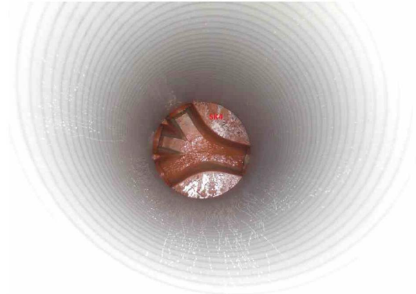
SK4SK4-128052108181A.jpg, 00:00:00, 0.00m Start inspeksjon / SK4
