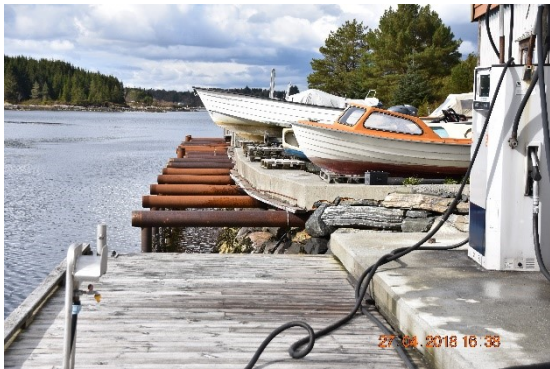
Drivstoffpume ytterst på kai. Det er på de utstikkene stålrør, at det planlegges å lage en kaifront i tre, samt også kaidekke i trevirke.
