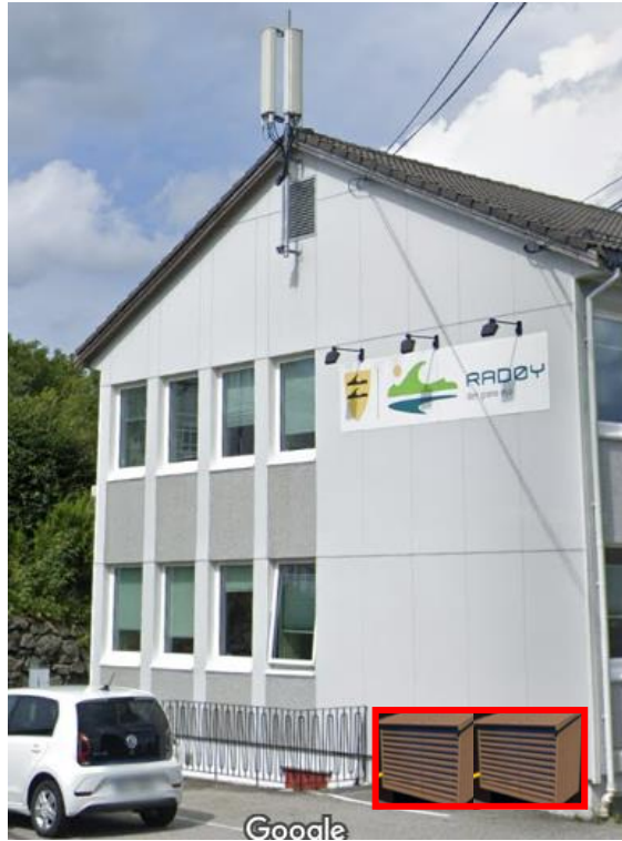
Figur 7: Seks radioenheter monteres inne i to «shelter» på fasaden, markert i rødt. «Shelter» males i fasadens farge.
