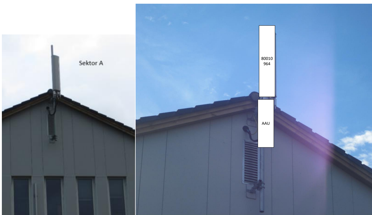
Figur 4: Punkt A, en eksisterende antenne (t.v) fjernes og to nye monteres (illustrert t.h) Dimensjon nye antenner h/b/d 1499/508/175 mm (80010964) og 699/395/160 mm (AAU5339w).
