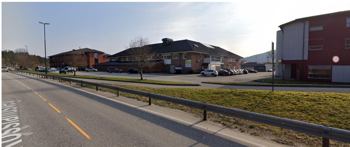
Figur 2: Bilde av eksisterende bygg. Tatt fra Rosslandsvegen. Hentet fra maps.google.com.
