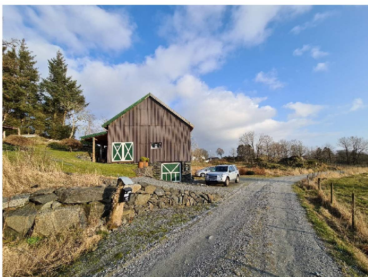
Løen sett fra nord. Porten i underetasjen går inn i tidligere høykjeller. Ny garasje legges som en vinkel ut fra løen (der hvor den bakerste bil står).
