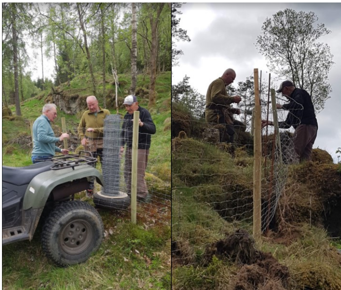
Figur 2 sjølvkonstruert hjelpemiddel til utrulling av not. Krevjande terreng og naudsynt med jernpålar
