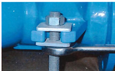
Fig. 3: Mutter på underside trekkes så til med 50 Nm
