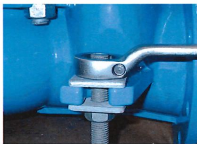
Fig. 4: Som avslutning på montering av enheten trekkes mutttrene til med 150 Nm på oversiden
