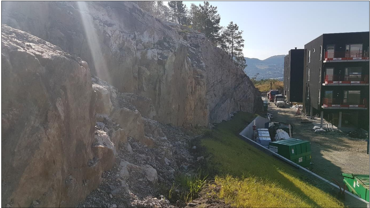
Figur 5: Oversiktsbilde av skjeringa frå området mellom bustadblokk B og C (fremste synlege bustadblokk i biletet). Biletet er tatt mot sør.
