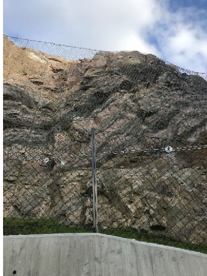
Sikring av fjellskjæring
