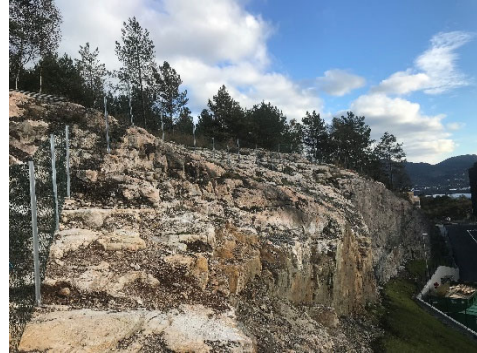
Sikring/gjerde langs toppen av skjæringen
