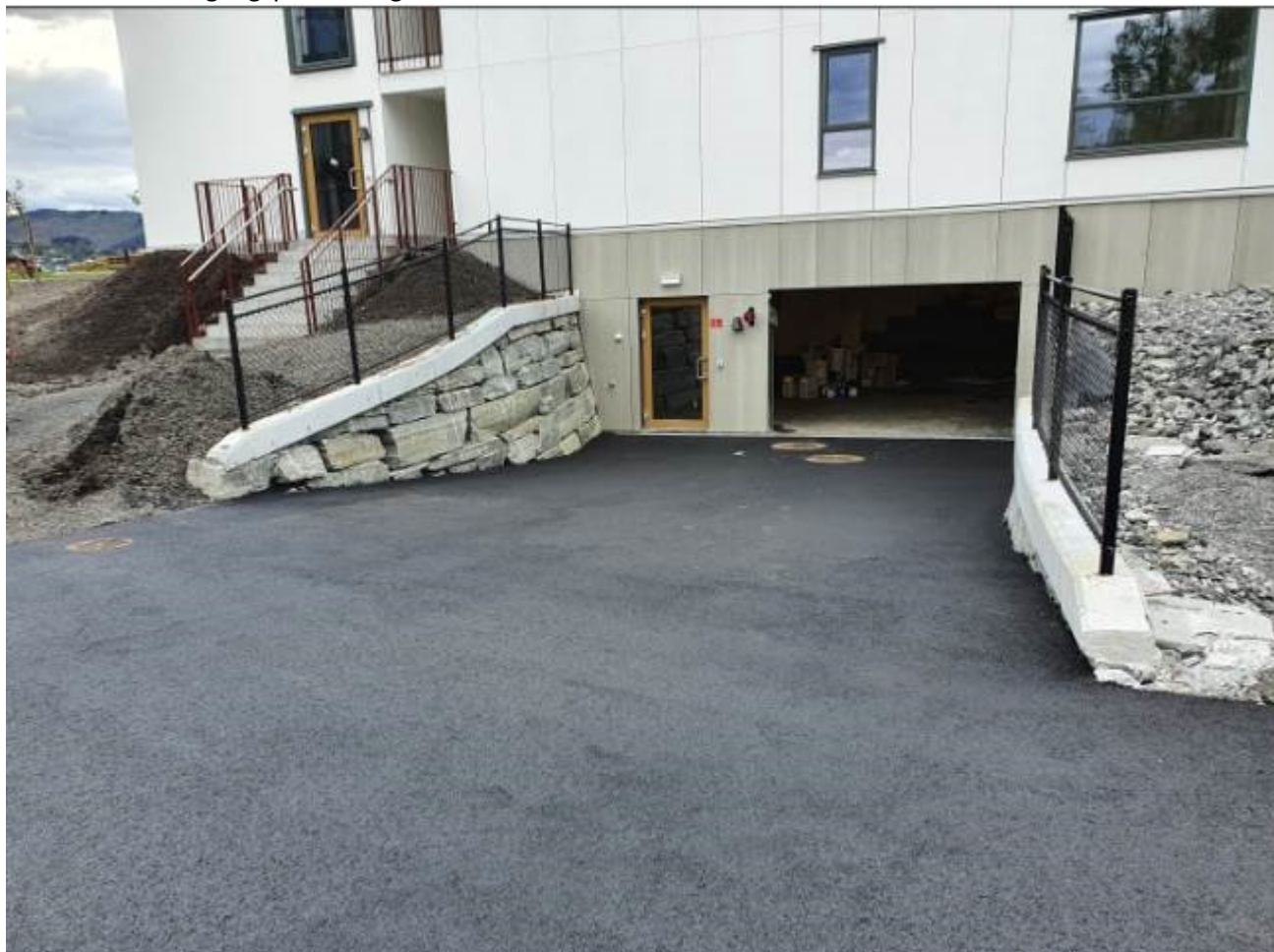
Rekkverk ved inngangsparti ferdigstilt
