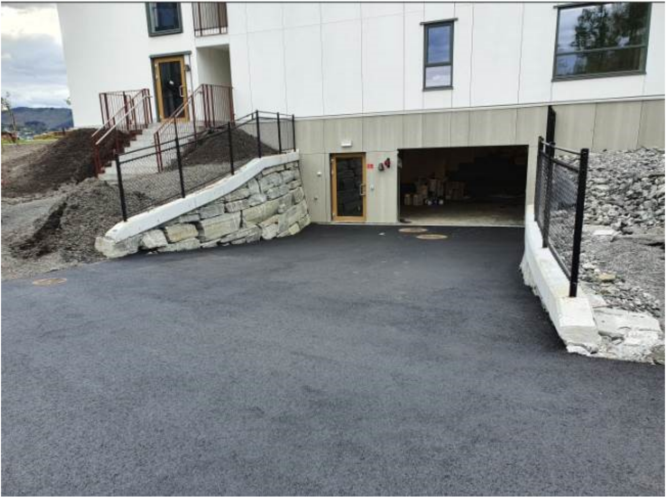
Utomhus asfaltering og grusing ferdigstilt
