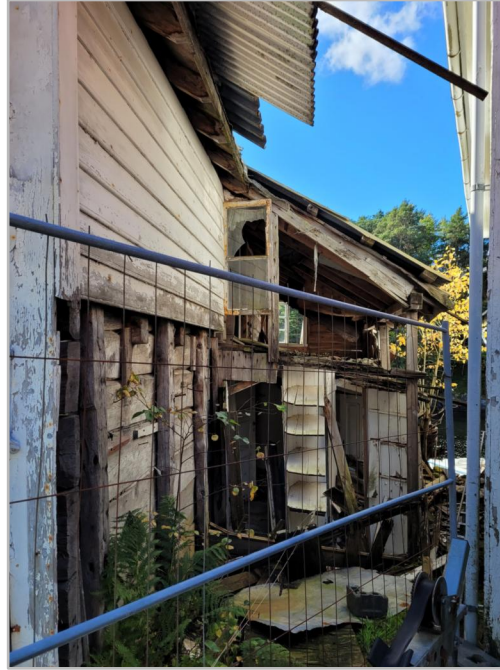
FASADE MOT NORD-ØST/NORD-VEST
