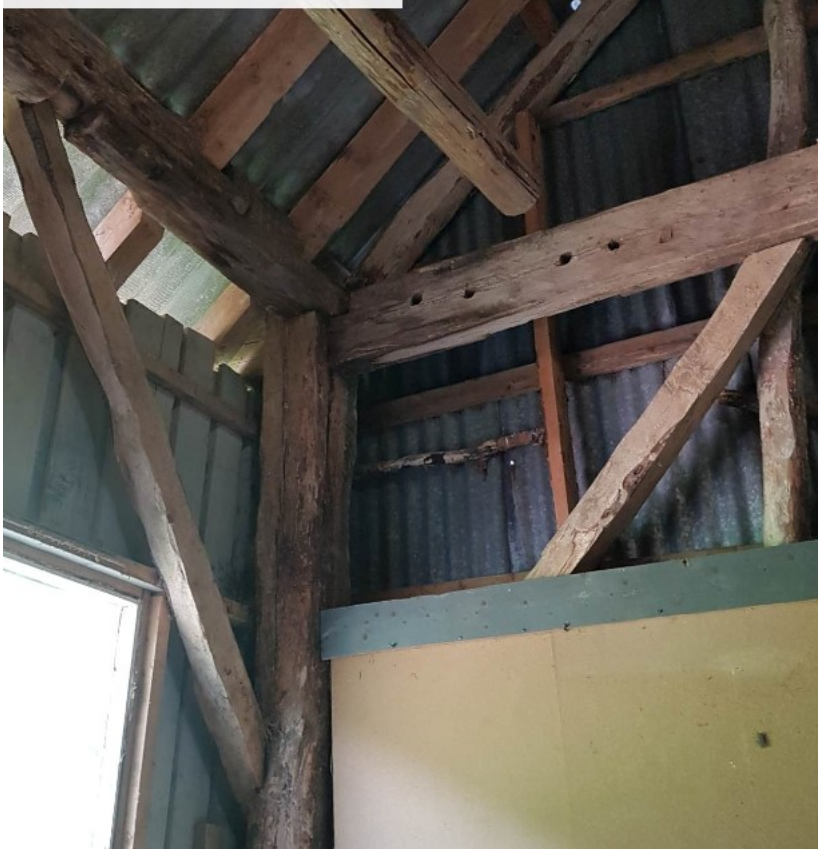
Figur 5 Råteskader/mitangrep låve
