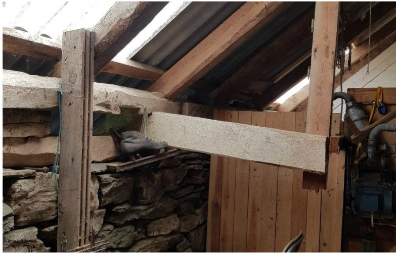
Figur 8 Toppsvill/stavlegga og avkappa hanebjelke
