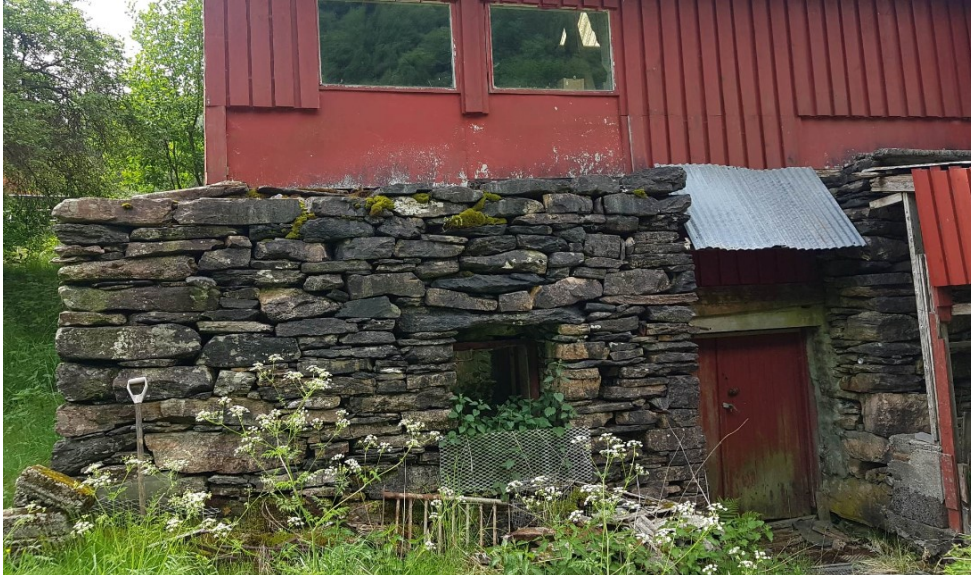
Figur 1 Inngang til kjellar
