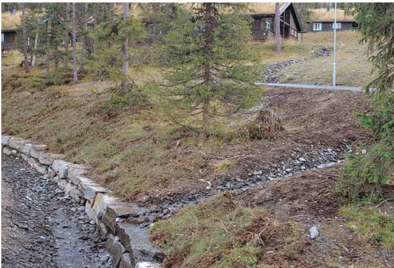
Naturtorv med mose og lyng på nyanlagt skråning, Gålå i Sør-Fron.
