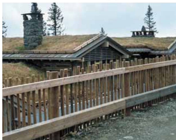
Gammel gjerdetype i ny utforming og med rekkverkfunksjon langs veggen
