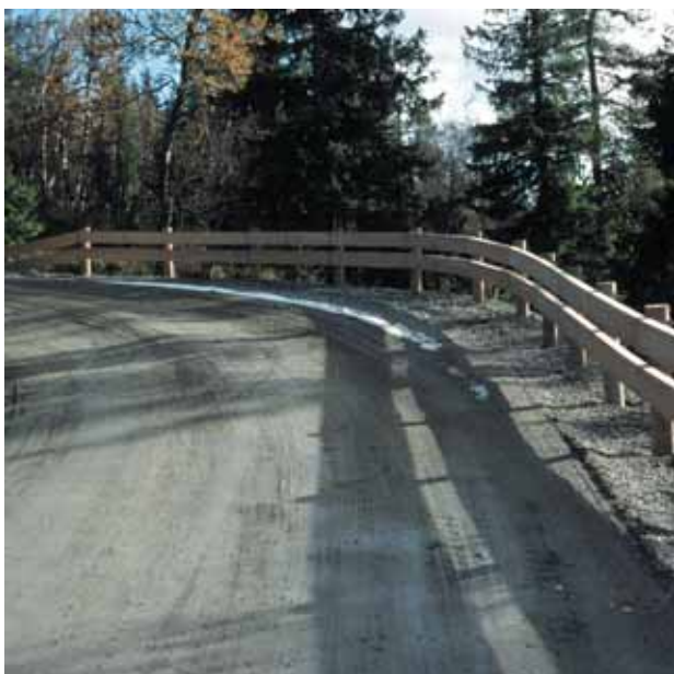
Rekkverk i tre i et hytteområde
