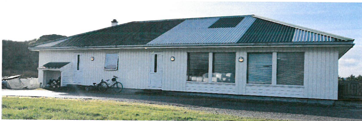
Fasade mot Riksvegen ( mot Nord-Aust)
