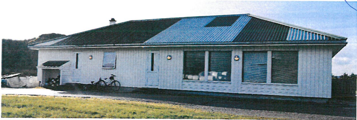
Fasade mot Riksvegen ( mot Nord-Aust)
