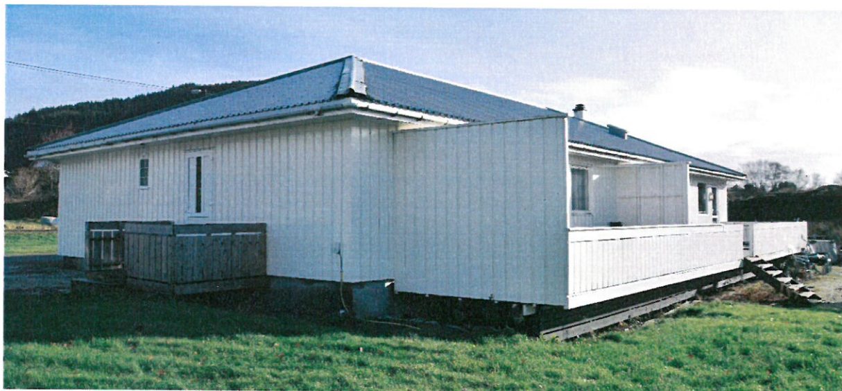
Gavlfasade mot Nord-Vest
