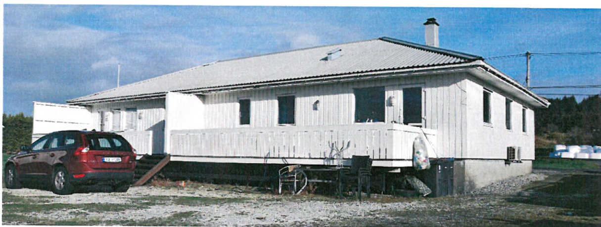
Fasade av langsiden mot Syd-Vest . Gavlfasade mot Syd-Aust
