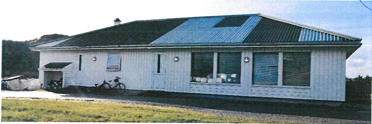
Fasade mot Riksvegen ( mot Nord-Aust)
