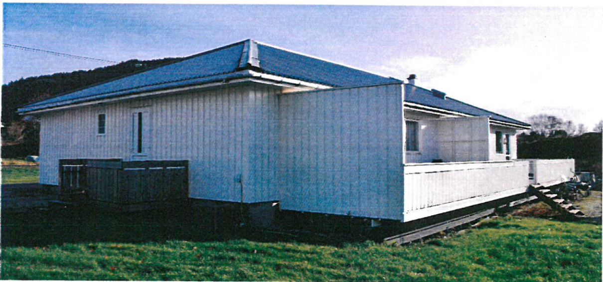
Gavlfasade mot Nord-Vest
