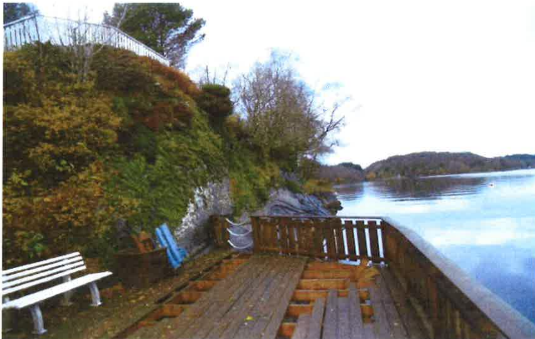
Foto: Schinnes Byggentrepnør AS 2012
