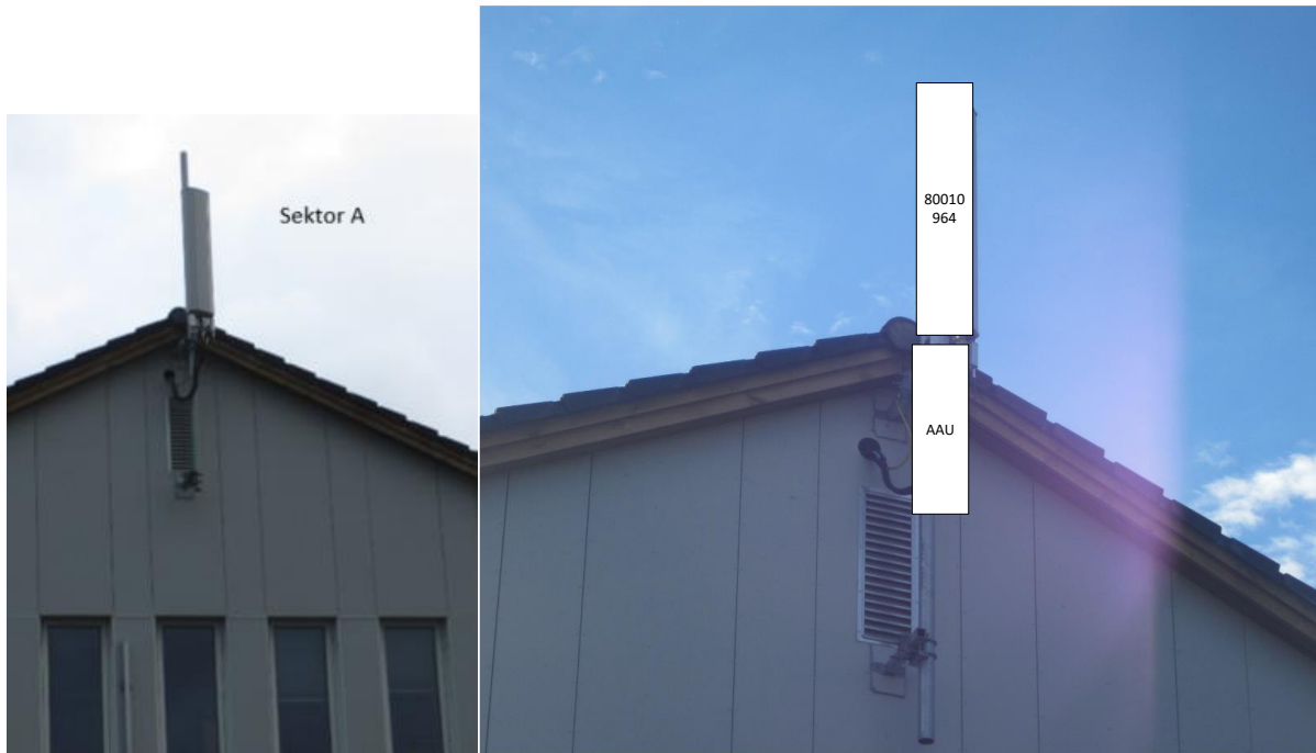
Figur 3: En eksisterende antenne (t.v) demonteres og to nye monteres (illustrert t.h) Dimensjon nye antenner h/b/d 1499/508/175 mm (80010964) og 699/395/160 mm (AAU5339w).
