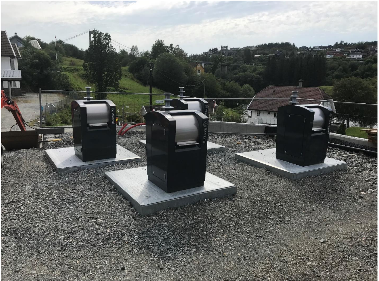
Figur 1: Døme på nedgravne konteinarar frå Alver brygge 26.07.2019 etter montering, men før ferdigstilling.
