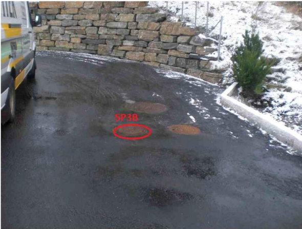
L26.11.2021 102917_SP3B_SP3A_261121_104141_8.jpg, 00:00:00, 0.00m Start inspeksjon / i SP3B
