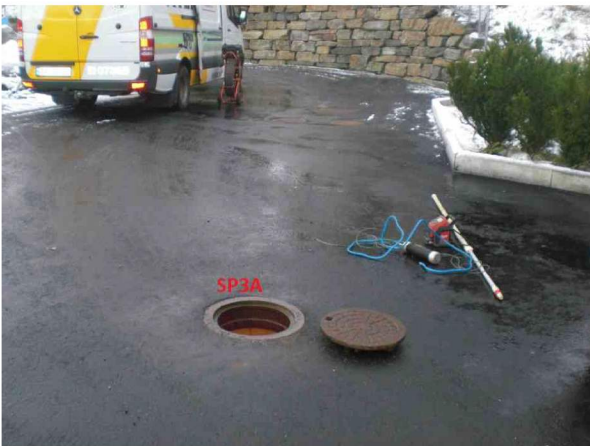
L26.11.2021 102917_SP3B_SP3A_261121_104141_10.jpg, 00:01:15, 6.36m Inspeksjon fullført / i SP3B
