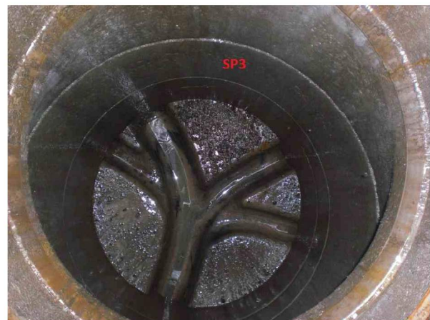
L26.11.2021 104312_SP3A_SP3_261121_120408_15.jpg, 00:00:06, 0.10m Retningsendring på 9 Kl., Prefabrikkert bend
