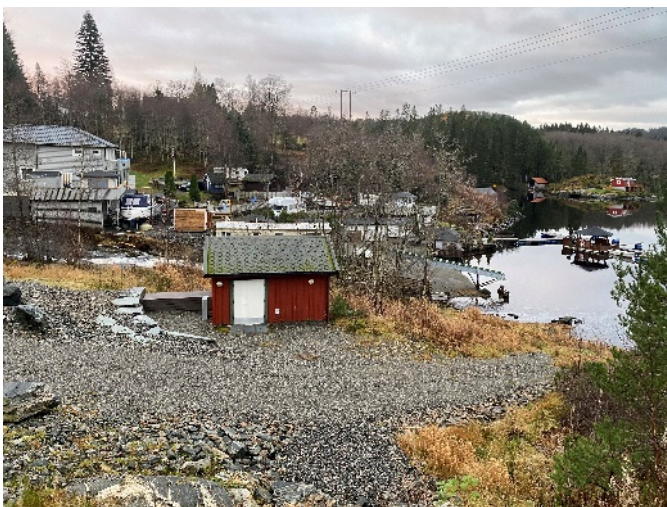
Eksisterende pumpestasjon sett mot sør
