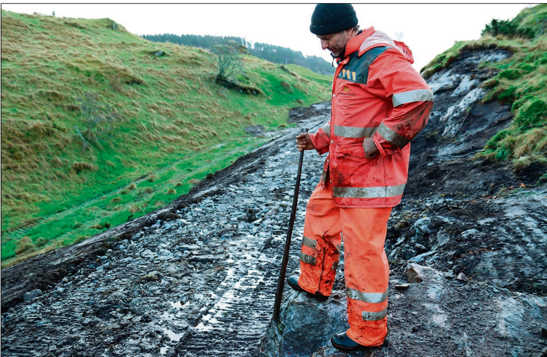
SPOR: Kulturminnefondet har løyvd 50 000 kr til istandsetjinga, og Sellevoll har late spora frå boringa på 30-talet stå att. (FOTO: VEGARD FLATØY)
