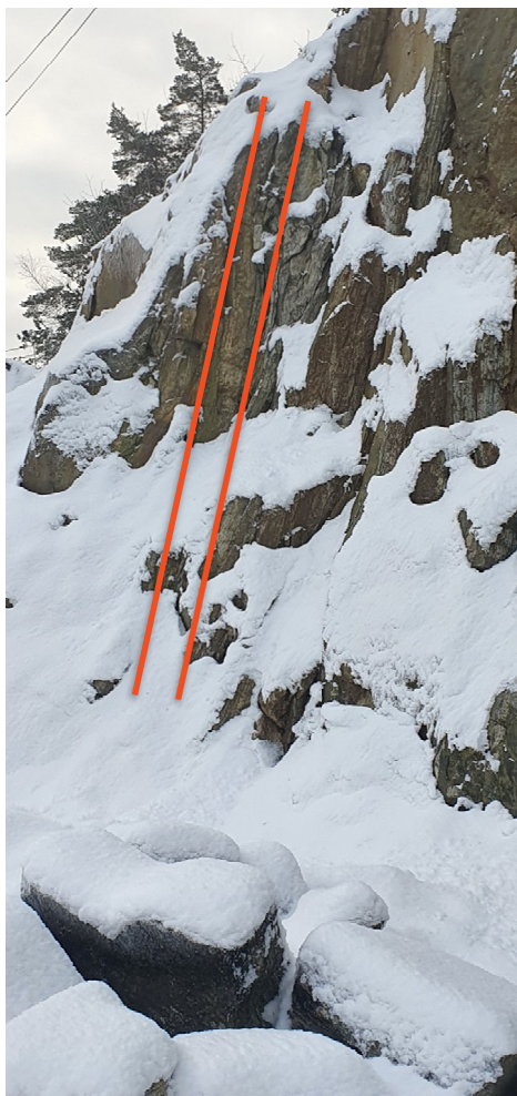
Figur 11 Bilde av lagdelingen i bergmassen. Bilde tatt mot SØ.
