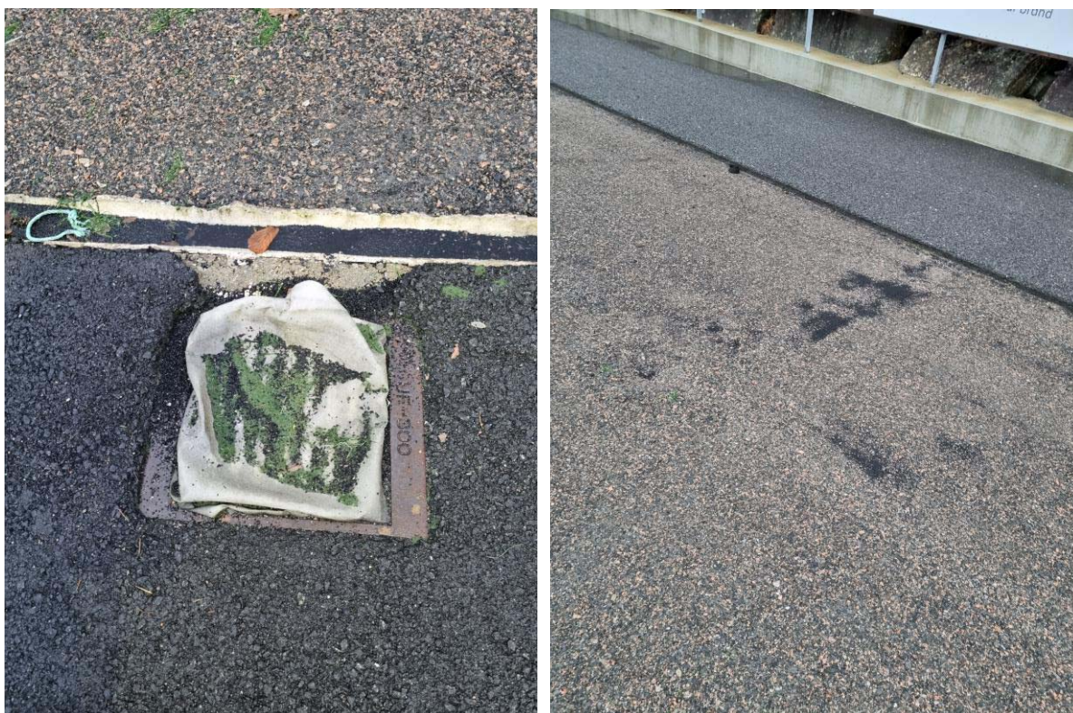
Figur 5-1 Bilde til venstre viser eksempel på bruk av filterduk i sluk rundt banen, som fanger opp kunstgressrester og gummigranulat. Bilde til høyre viser eksempel på ansamling av gummigranulat oppå topplaget langs kanten av banen.
