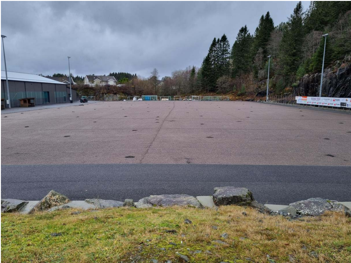
Figur 4-2 Tiltaksområdet ble inndelt i 8 omtrent like store delområder, og det ble gravd groper for uttak av 10 stikkprøver i hvert delområde. PG1 er delområdet nærmest til venstre, mens PG8 er delområdet nærmest til høyre. Bildet ble tatt like etter at prøvetakingen var ferdig. Bildet er tatt mot sørvest. Kilde: Multiconsult.
