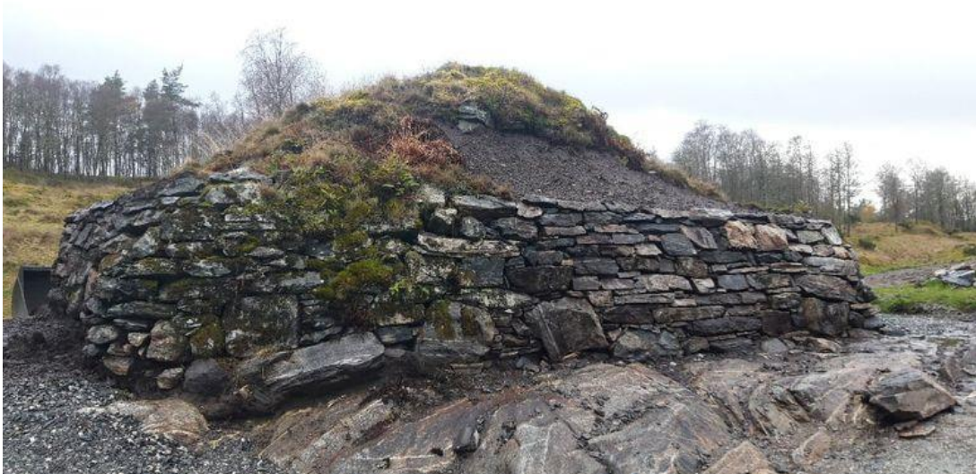
Over: Det lengste partiet etter istandsetjing. Det vender inn mot veg til gardstunet, grovt sett i nordvestleg retning. Her var dei mest påfallande skadane der delar av murverket heldt på å rasa ut. Fotoet viser også at ein har utført etterfylling med jord i mellomrommet mellom inner- og yttermur.
