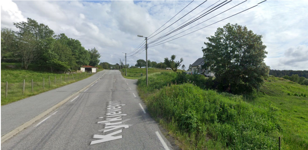
Bilde av dagens situasjon sett fra nord (langs fylkesvegen)
