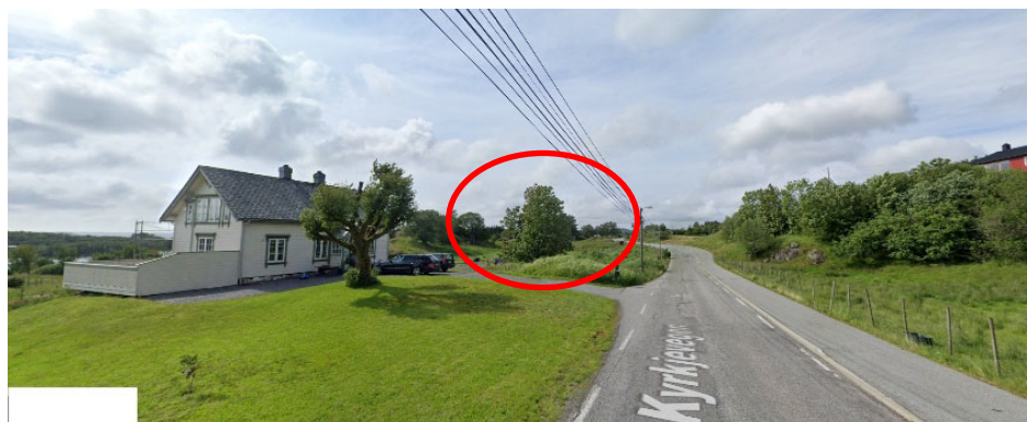
Dagens situasjon - sett fra sør. Rød sirkel markerer området der tiltaket er tenkt plassert.
