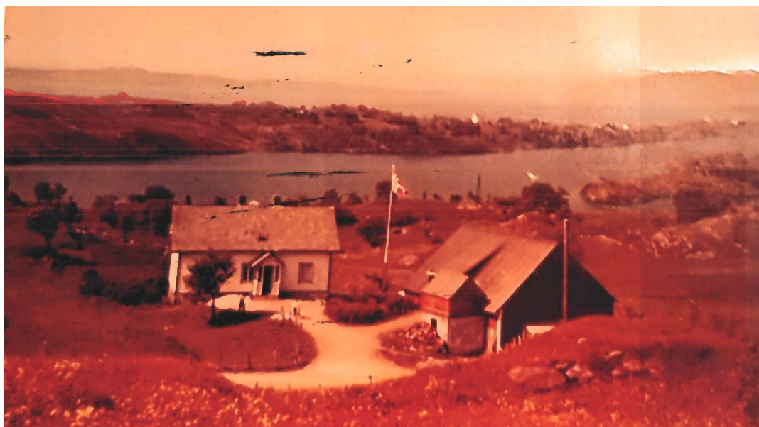
Det gamle bruket sett fra øst mot vest, med hovedvegen i forkant. Bildet viser hvordan låvens plassering i terrenget muliggjorde tilkomst fra tunet til høy-loftet.
