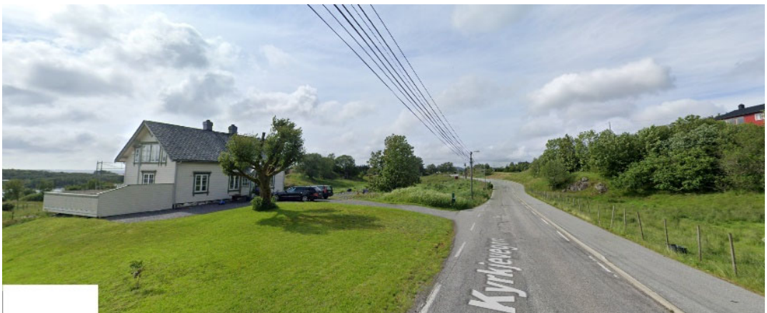
Bilde av dagens situasjon sett fra sør (langs fylkesvegen)
