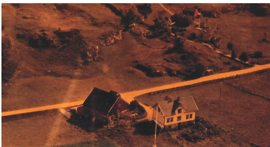
Flyfoto av gården, sett fra nord-vest (antatt 1960-tallet). På bildet ser man hvordan den gamle låven var plassert i skrånningen mellom gårdsplassen/tunet og beitemarkene på nord -og vestsiden.
