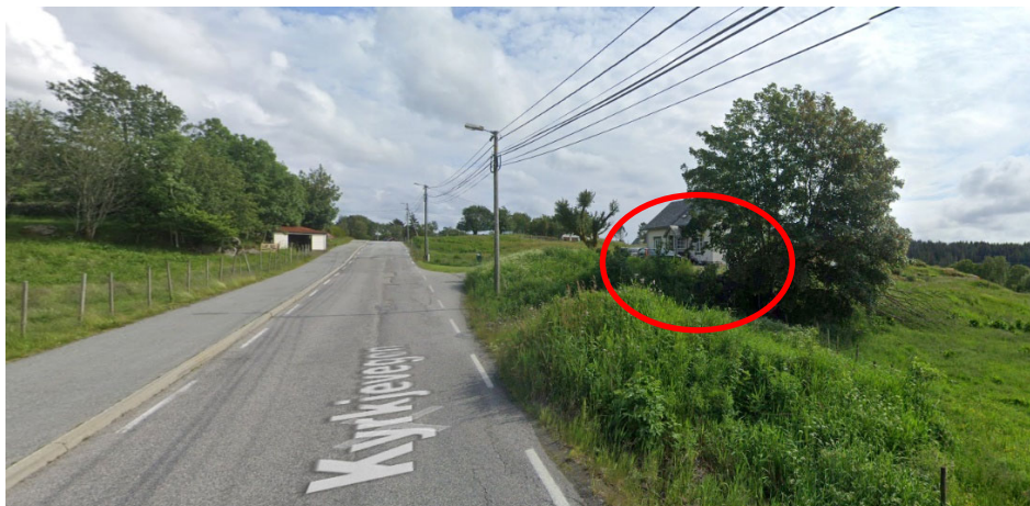
Dagens situasjon - sett fra nord. Rød sirkel markerer området der tiltaket er tenkt plassert.
