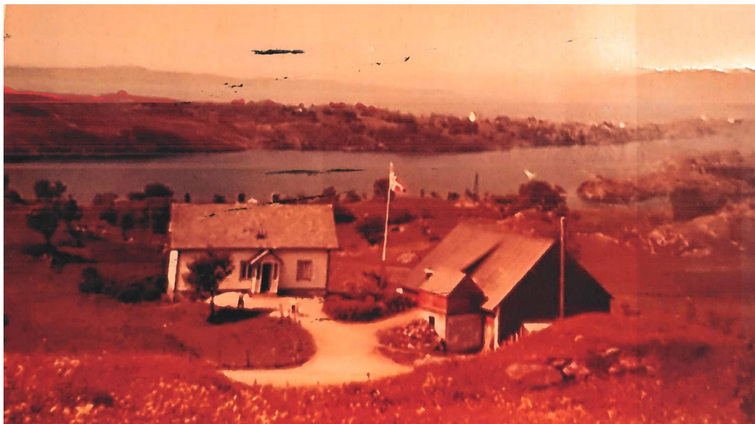
Det gamle bruket sett fra øst mot vest, med hovedvegen i forkant. Bildet viser hvordan låvens plassering i terrenget muliggjorde tilkomst fra tunet til høy-loftet.
