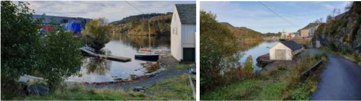
Figur 5-4: Bilde tatt på befaring som viser situasjonen i strandsonen nord og sør for Framo-området. Bildet til høyre viser sjøkant på eiendom 1/6 mens bildet til høyre viser sjøkant på eiendom 1/6.
