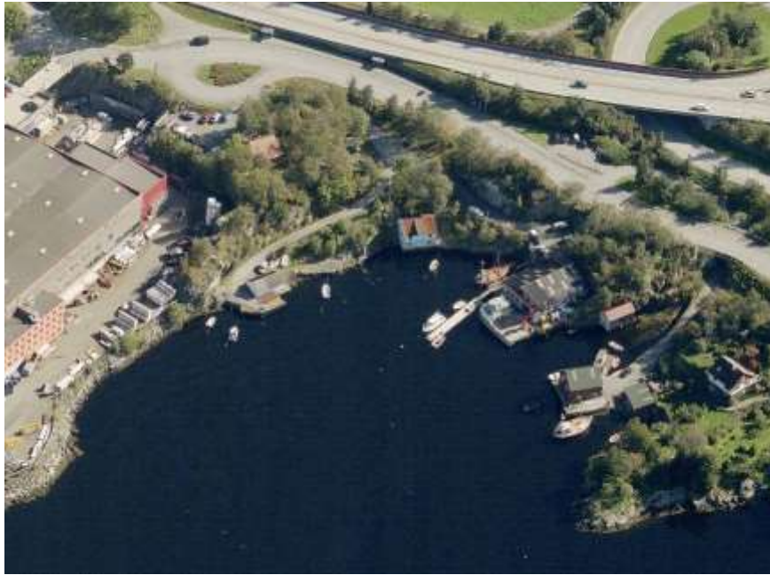
Figur 6-10 Flatøy kai sett mot sørøst
