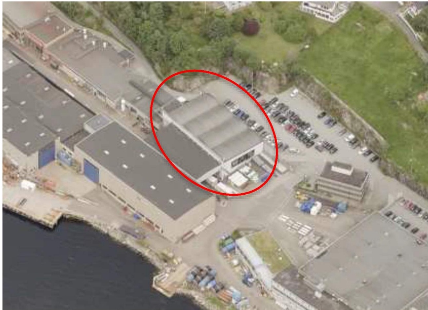
Figur 6-4 Skråfoto av flyhangaren. Flyhangaren er vist med rød sirkel. Kilde: 1881
