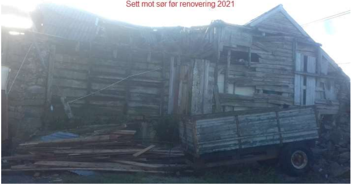
Sett mot sør etter renovering 2021
